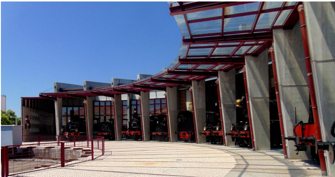
Rond-point des locomotives Vue générale
